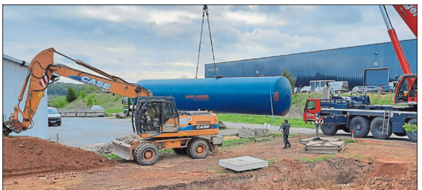
Mit einer großen Zisterne will die Stadt Diemelstadt die Löschwasserversorgung im Gewerbegebiet Rießen sichern. Die Kommune will sich damit auch vor möglichen Klagen schützen.
