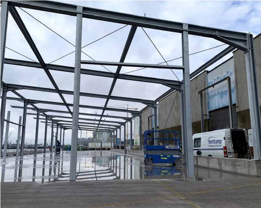
Die feuerverzinkte Stahlkonstruktion in der Terminalhalle widersteht Bränden bis zu 30 Minuten.
