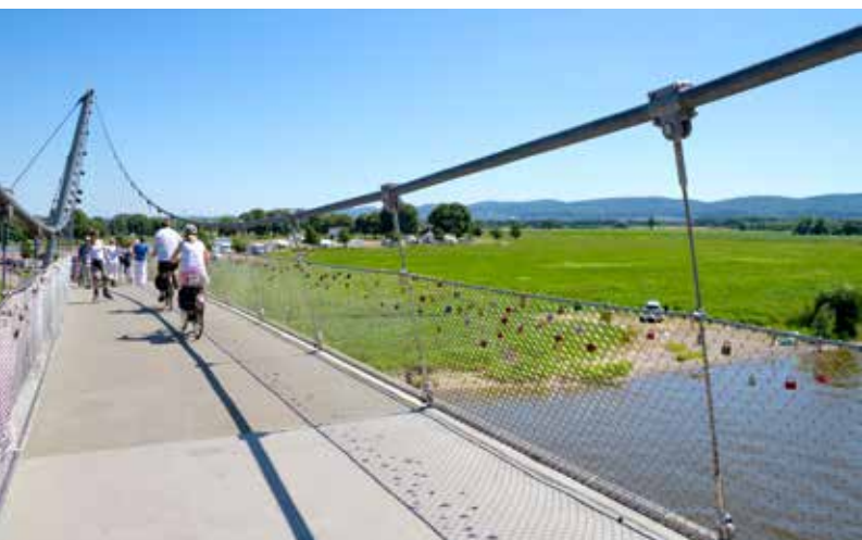
Weserbrücke in Minden
