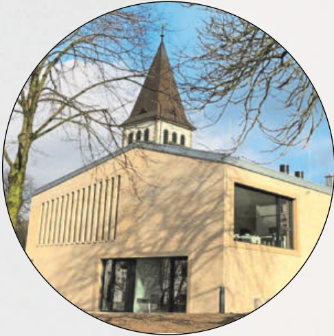
Neubau eines Pfarrheims, Mackebenstraße 15, Bielefeld-Brackwede Foto: Stefan Terbrack
