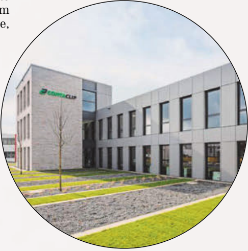
Bürogebäude mit Hallenerweiterung, Otto-Hahn-Straße 7, Hövelhof Foto: Dennis Neuschaefer-Rube
