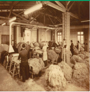
1954 Faseraufbereitung in der ersten Produktionsstätte in Espelkamp
