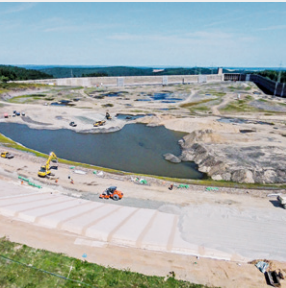
2015 Staudammsanierung am Pumpspeicherwerk Ho- henwarte II mit Bentofix® mit einer 10 kg/m 2 schwe- ren Bentonitfüllung (Deutschland)
