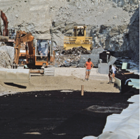
1985 Depotex® aus PEHD Fasern als Schutzlage in einer Deponie (Deutschland)
