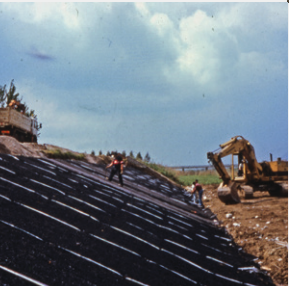
1989 Erosionsschutz mit Secumat® an einer Flussböschung (Italien)
