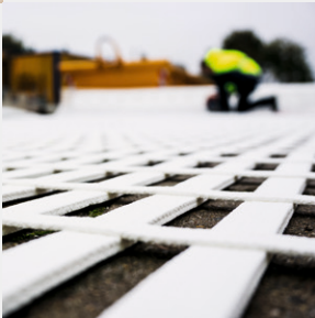
2016 Segugrid® HS hochzugfeste Geogit- ter sichern tragende Gewölbestruktur unter dem Straßenauf- bau (Deutschland)
