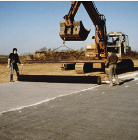
1987 Verlegung von Bentofix® auf einer Deponieoberfläche (Deutschland)
