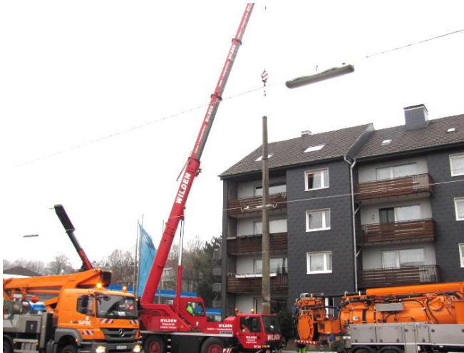
Austausch defekter Abspannmasten für die Seilverspannung
