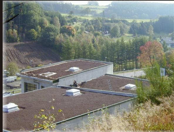
Zunächst werden die drei jeweils traufabgewandten Seiten sowie die Lichtkuppelfelder als Kiesstreifen bzw. Kiesbetten ausgebildet. Später werden die Kiesfangleisten für den Traufenbereich vorbereitet. Diese bestehen aus feinstrukturiertem Lochblech.<sup>8)</sup>
