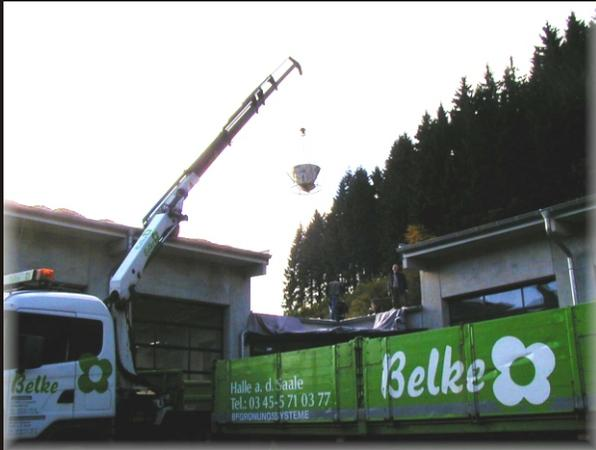
Der Kies für die Randeinfassung in Korngröße 16/32 wird angeliefert und per Kran auf das Dach gehoben.<sup>7)</sup>
