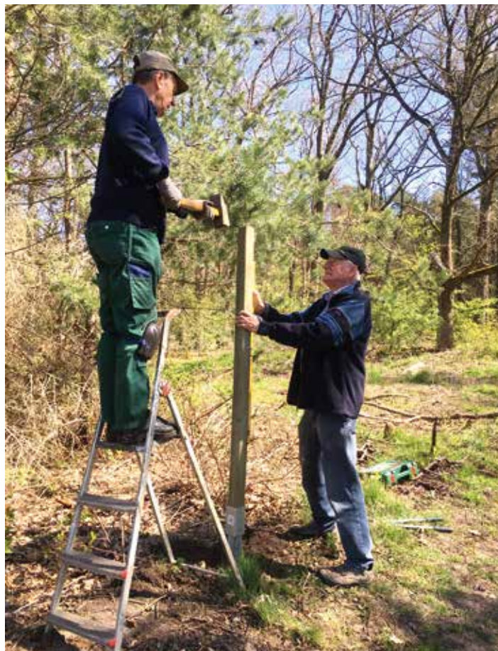
Hans-Jürgen mit »Mottek« und Werner mit Wasserwaage im Einsatz.
