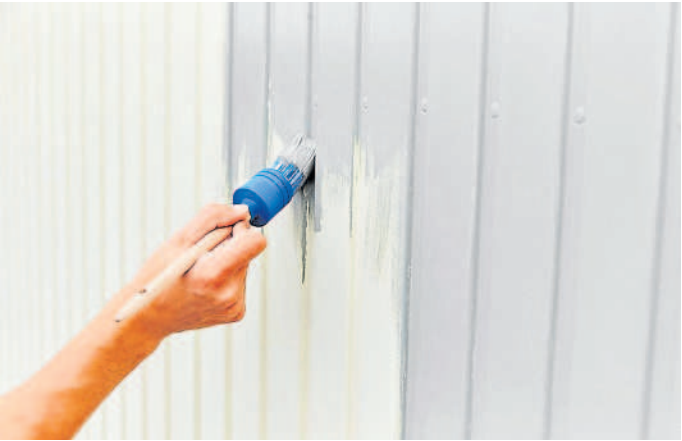
Vor dem Lackieren sollte das Tor zunächst grundiert werden.
