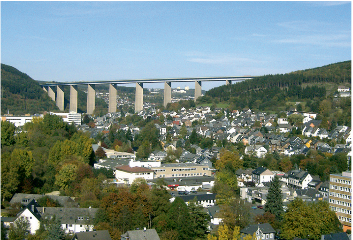
Die Siegtalbrücke ist mit einer Spannweite von 1.050 m eines der größten Brückenbauwerke im Verlauf der A45.
