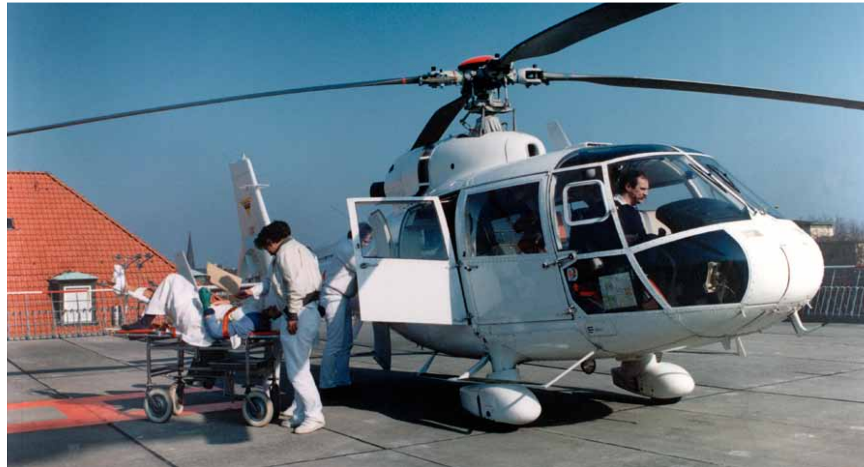
Hubschrauberlandeplatz auf dem Dach des 1984 fertiggestellten Untersuchungs- und Behandlungstraktes (64)
