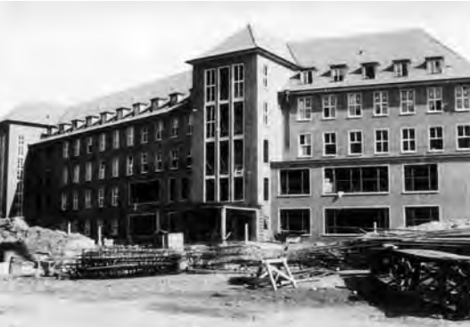
Haus II im Bau, 1950 (48)
