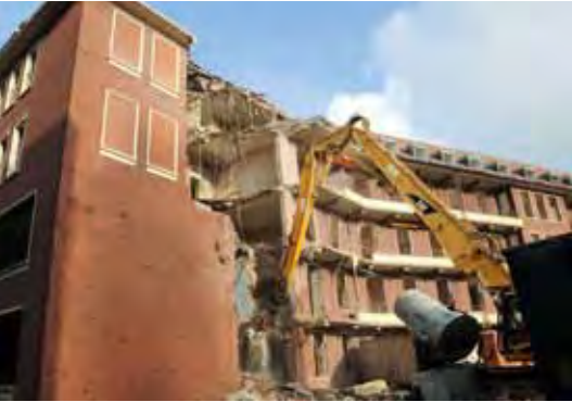
Abriss des alten Hauses III, 2007 (69)
