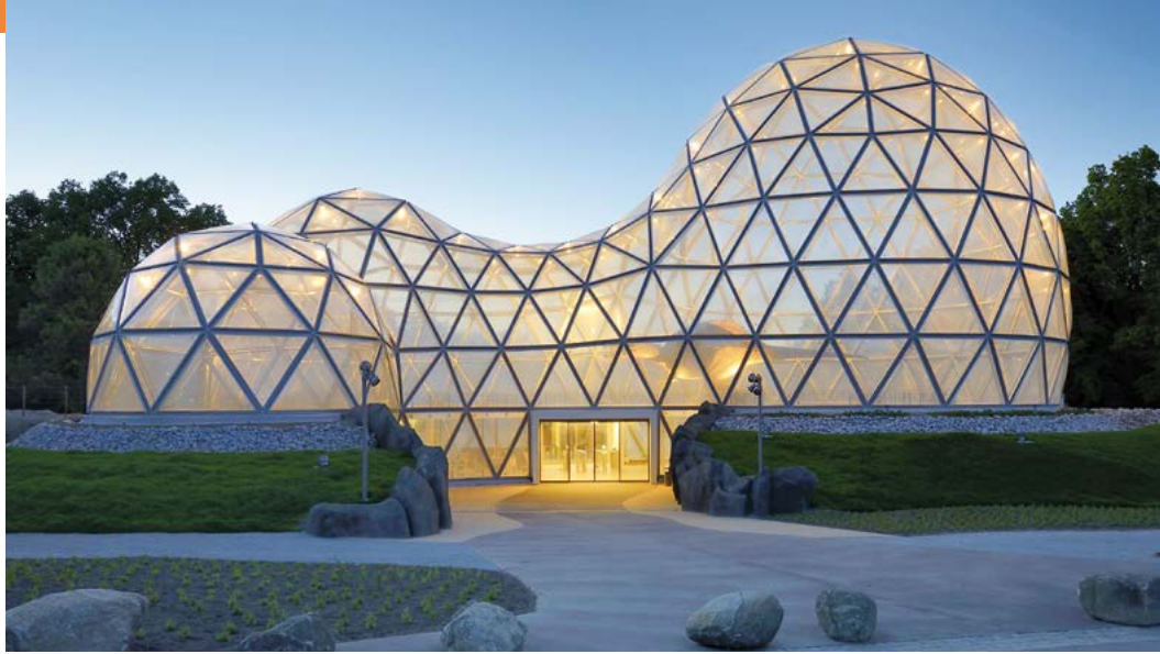
Das neue Eingangsportal Mitoseum.
