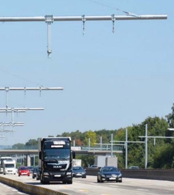
Die Bauarbeiten zur Errichtung der Oberleitungsinfrastruktur haben im März 2018 begonnen.
