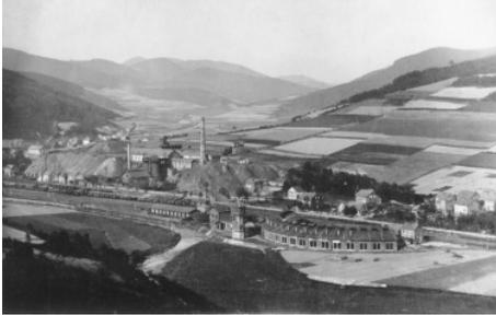
Blick auf Altenhundem, um 1890. Im Vordergrund das Bahnbetriebswerk mit dem großen Ringlokschuppen. Die Lokomotiven wurden auf der Steilstrecke zwischen Altenhundem und Welschen Ennest als Schiebeloks eingesetzt
