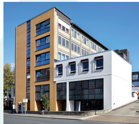
Für die Dialyseabteilung des St. Vincenz-Krankenhauses wurde oberhalb der Cafeteria ein ganz neues Geschoss gebaut.
