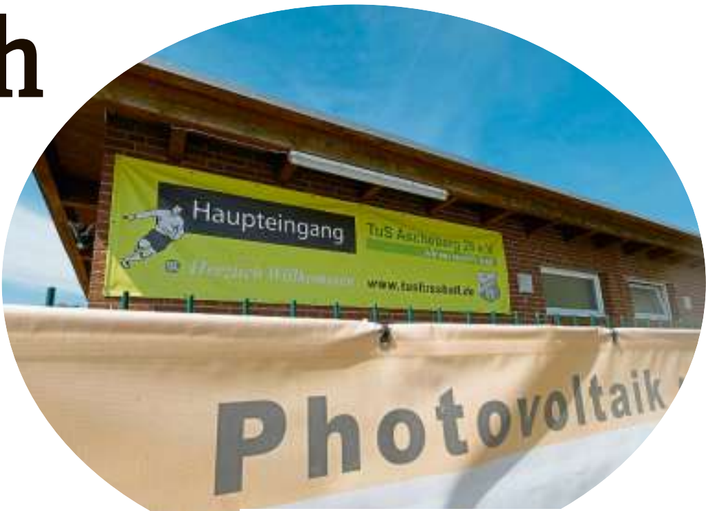
Die Sportanlage an der Nordkirchener Straße wird über die Photovoltaikanlage auf dem Dach der Profilschule versorgt. Foto: Siegmars Syffus
