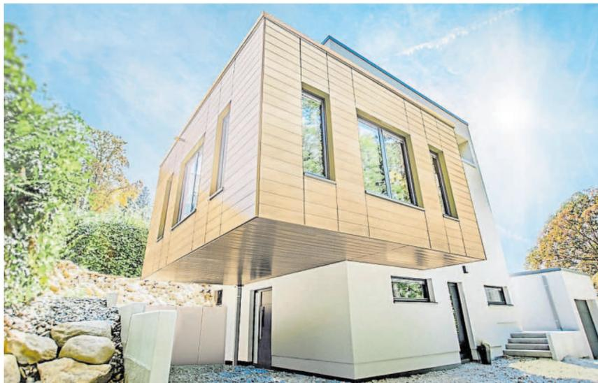
**Beeindruckend: Was aussieht wie ein Kubus mit einer Holzfassade, entpuppt sich bei näherer Betrachtung als eine Gebäudehülle aus Aluminium. Denn die Fassadensidings verbinden die natürliche Optik von Holz mit den funktionalen Vorteilen von Aluminium.**
