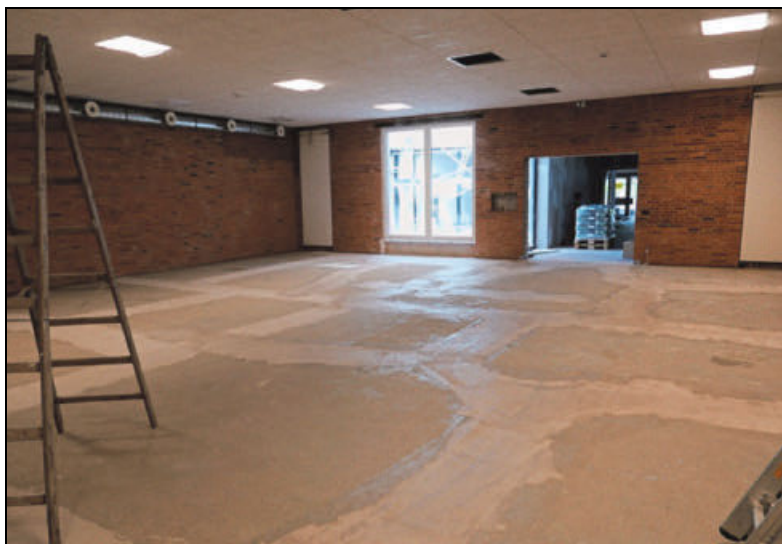
Blick in die sehr große Multifunktionshalle, hier auf dem Foto noch im Rohbau.
