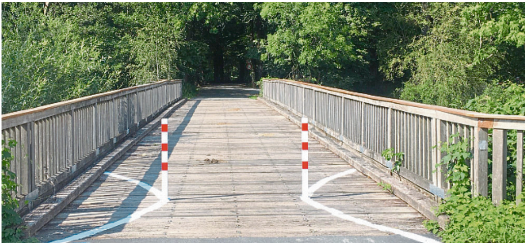
Für Autos, Lkw und Traktoren ist die Emsbrücke am Haus Langen gesperrt.
