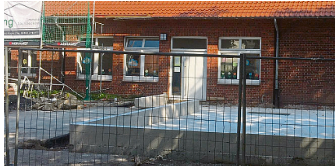
Der Anbau für die Zweigstelle der Kita „Sternzelt“ darf errichtet werden, Bedarf gibt es noch in Sachen Brandschutz. Foto: -stk-
