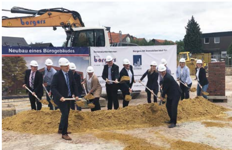
Der erste Spatenstich ist gesetzt: Borgers baut für Heisterborg eine neue Verwaltung.
