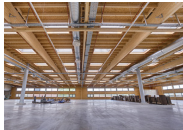
Die Produktionsebenen sind beinahe stützenfrei.
