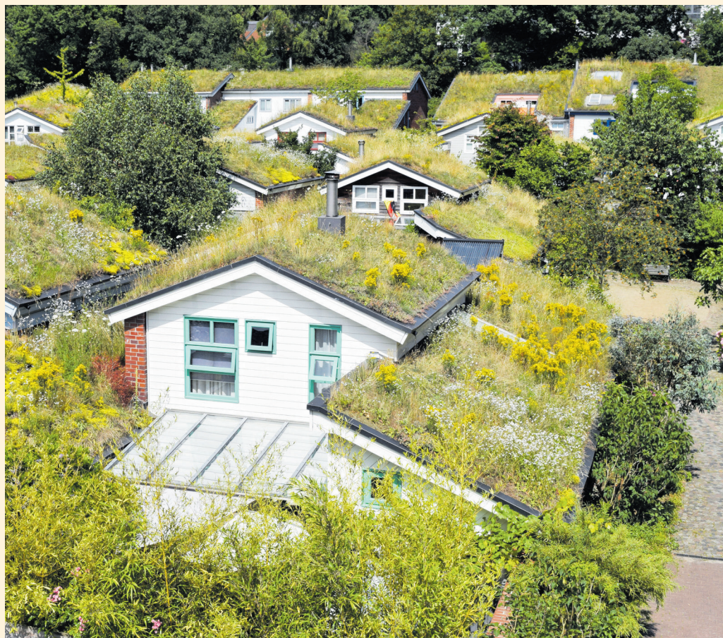
Dachbegrünungen werden von der Gemeinde finanziell gefördert.
