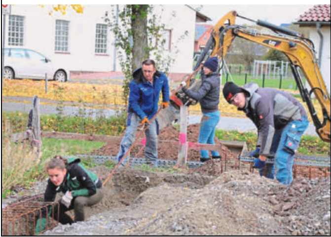
Erste Arbeiten für das Fundament erledigen hier Vorarbeiter Uwe Leidner von der Firma Hartmann-Bau (2. von links) und die ehrenamtlichen DLRG-Helfer Esther Häberle (von links), Jana Albers und Simon Tewes. Fotos: Wilhelms
