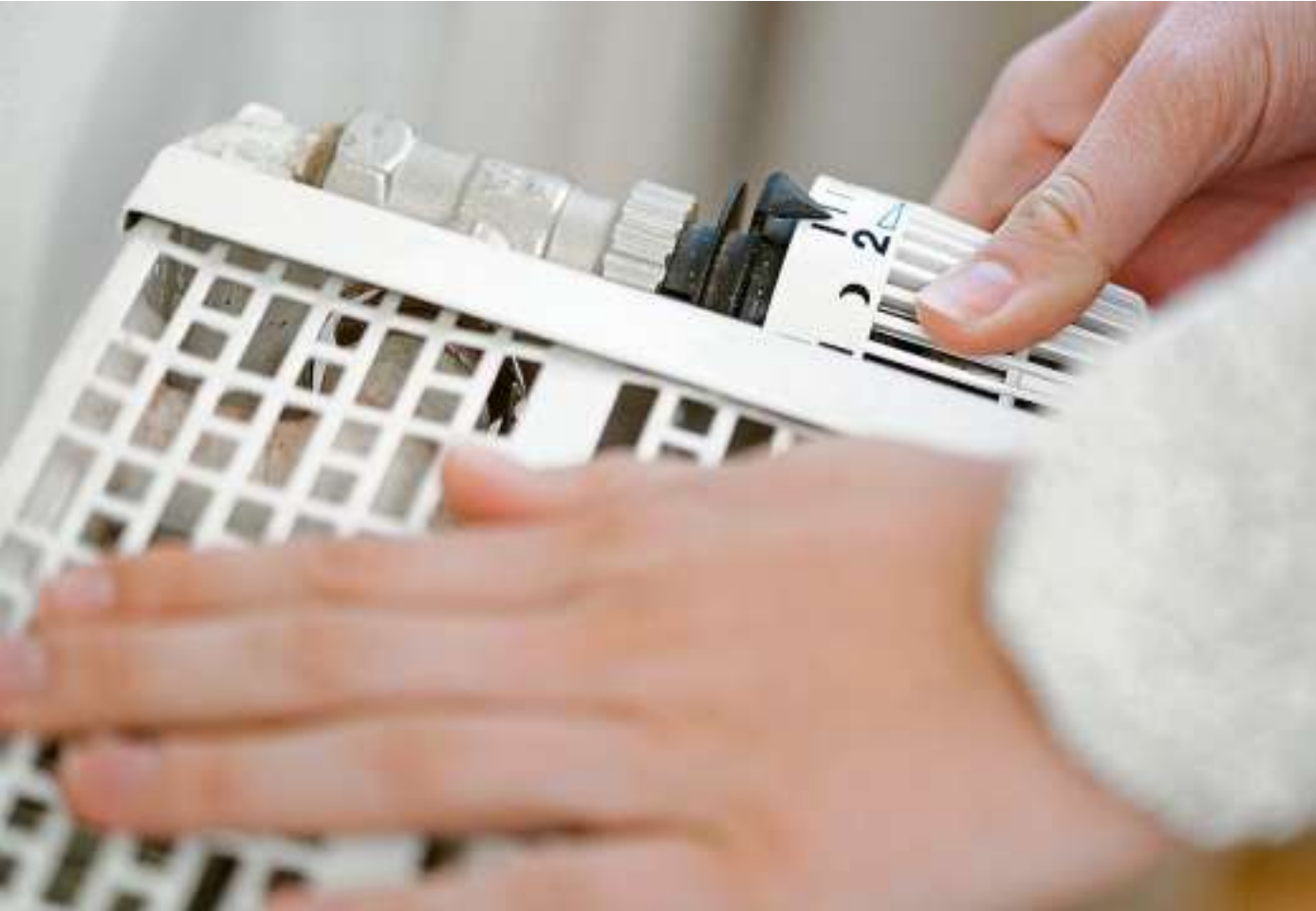
Um zu vermeiden, dass die Rohre zufrieren, sollte die Heizung in der kalten Jahreszeit nie ganz ausgeschaltet werden. Foto: dpa
