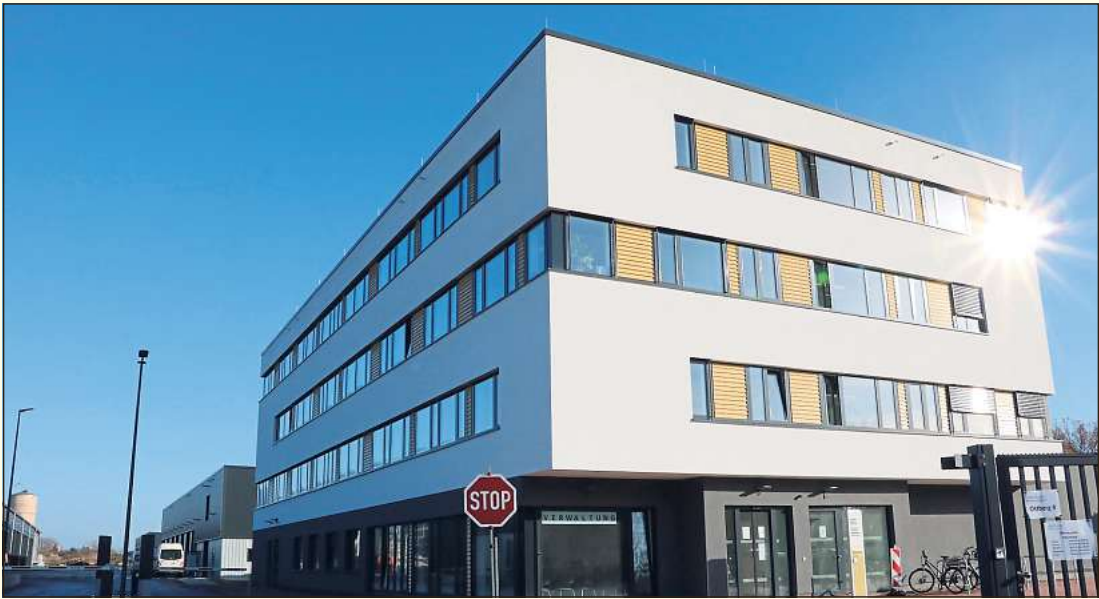
Als erstes Gebäude ist im rechten Teil des Areals am Ostberg der Verwaltungsbau der Ahlener Umweltbetriebe entstanden. Nachträglich in die Planung wurde das oberste Stockwerk als Sitz des Zentralen Gebäudemanagements der Stadt Ahlen (ZGM) mit aufgenommen. Fotos: Wittmann
