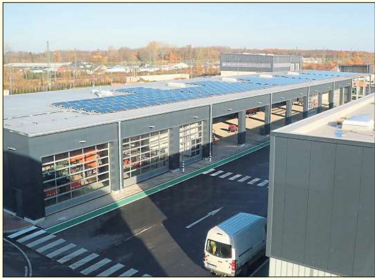
Blick vom Verwaltungsgebäude auf den Baubetriebs- und Wertstoffhof der Stadt Ahlen am Ostberg 4. Das große Gebäude ist die Fahrzeughalle. Foto: Wittmann
