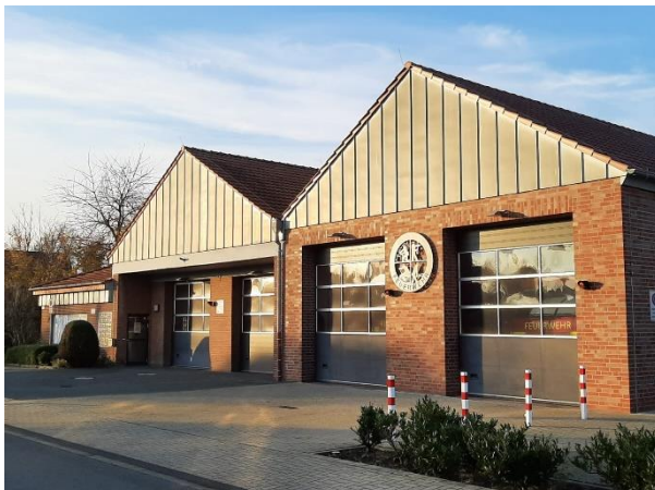
Erweiterung des Feuerwehrgebäudes in Walstedde
