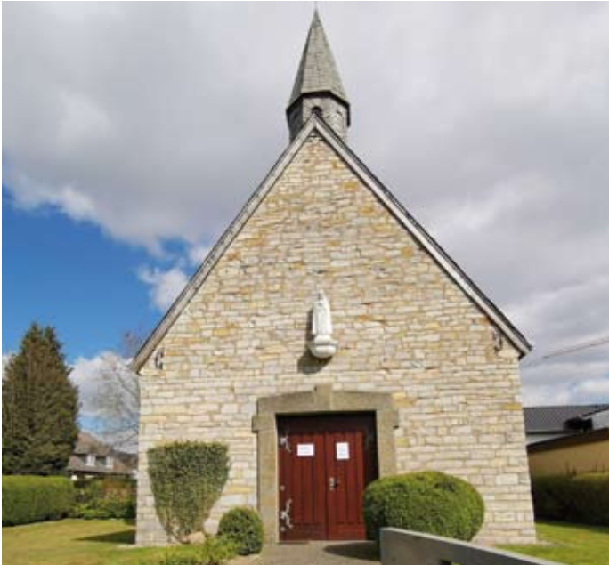
Die Fatima-Kapelle an der Straße Zur Warthe
