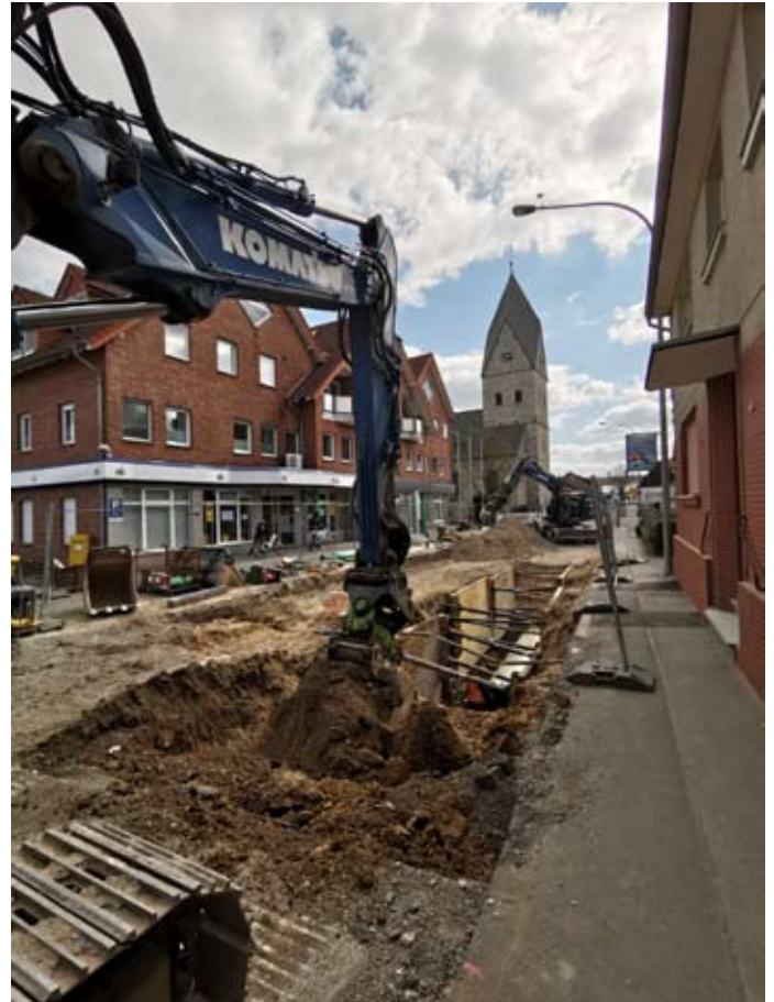
Der dritte Bauabschnitt zwischen der Sparkasse und der Kirche ist in diesem Sommer fertiggestellt worden.
