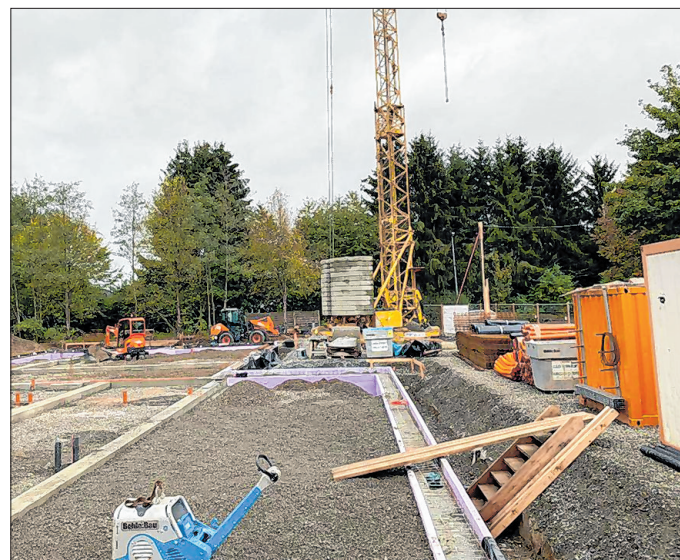
Ein Blick auf die Baustelle der DRK-Rettungswache Anfang Oktober.
