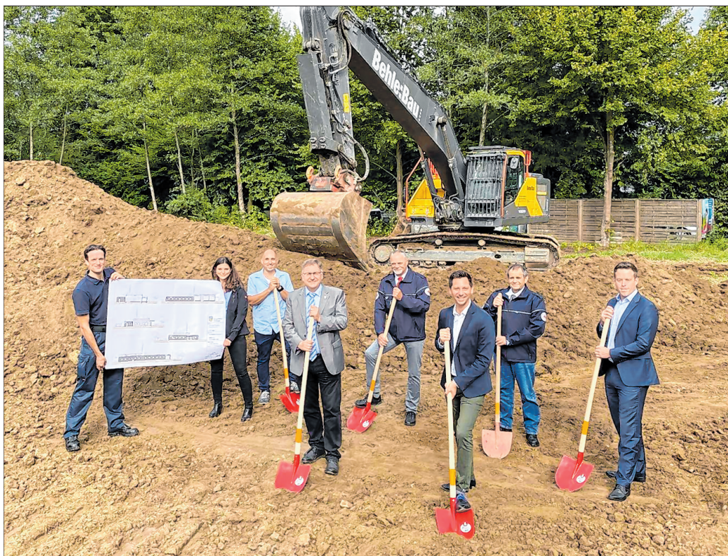
Landrat Andreas Müller hatte zum ersten Spatenstich für die neue Rettungswache geladen. Mit dabei u.a. Bürgermeister Paul Wagener, Architektin Sophie Rinn, Vertreter des Bauunternehmens, des DRK und des Amtes für Brand- und Bevölkerungsschutz, Rettungswesen des Kreises.
