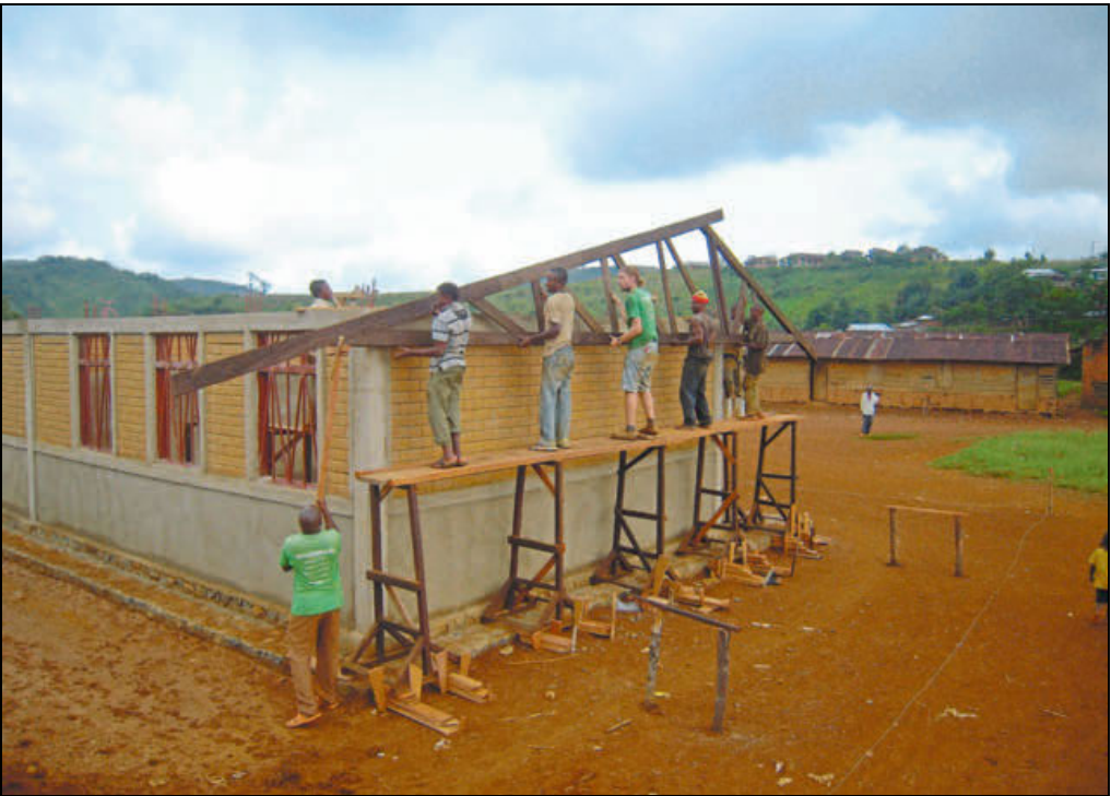
Simon Bethlehem steht im Kongo mit Einheimischen auf einem Gerüst und errichtet den Dachstuhl einer Schule. Foto: Grünhelme
