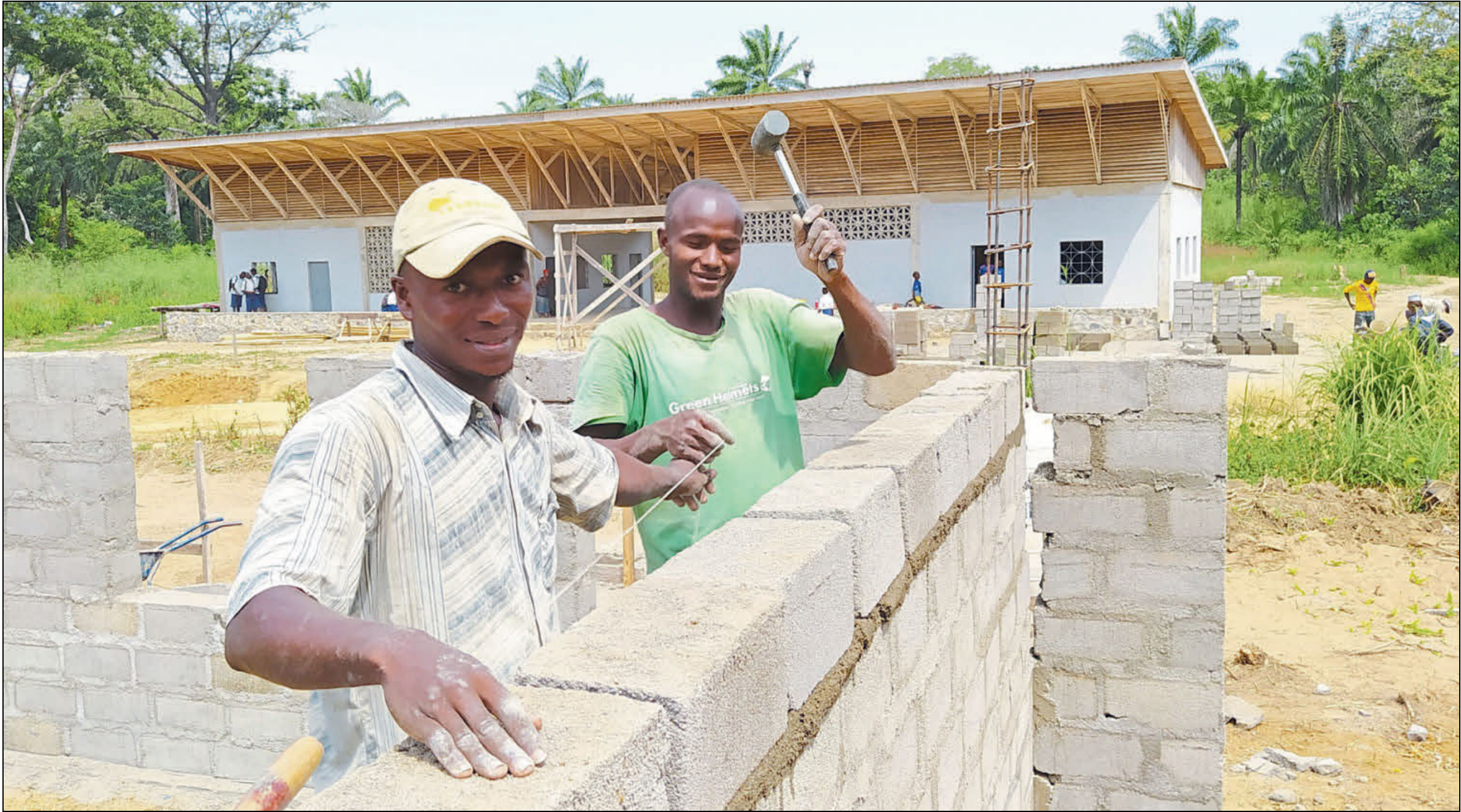
Josef und Karefa helfen beim Bau der Schule in Mansadu. Tischler Simon Bethlehem aus Gütersloh hilft mit, schult die Männer und überwacht die Arbeiten.
