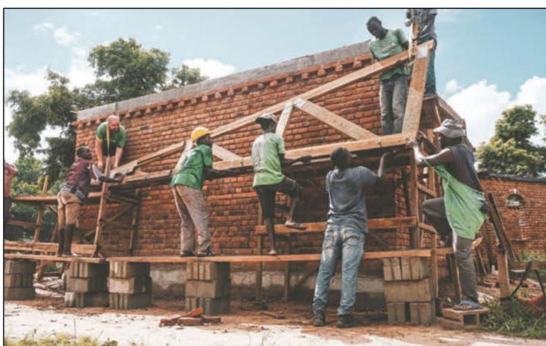
Mit vereinten Kräften wird der Dachstuhl errichtet: Hier lässt sich schon etwas erahnen, wie die neue Schule einmal aussehen wird.
