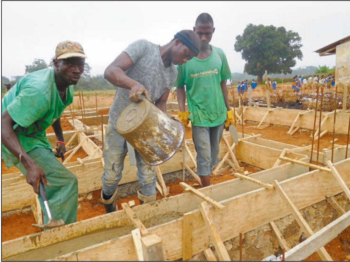
Die von den Grünhelmen beschäftigten lokalen Arbeiter beim Betonieren.
