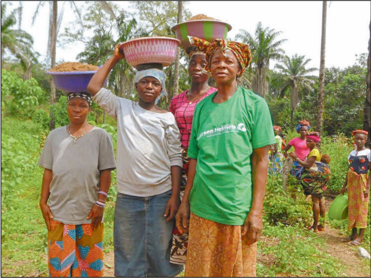
Die Frauen holen Sand für den Beton aus dem Fluss.
