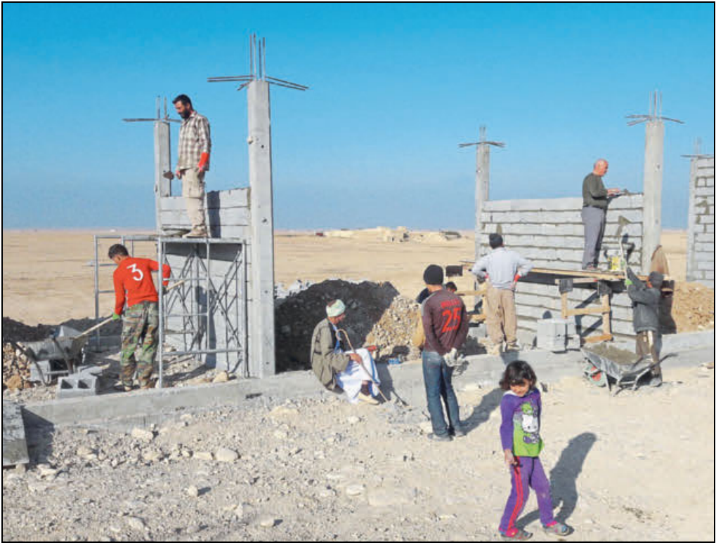
Mauern und betonieren: Viele halfen bei den Bauarbeiten mit.
