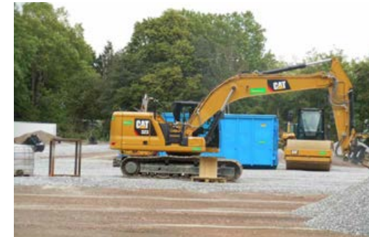
Zurzeit wird auf der Leichtathletik-Anlage des BV Teutonia Lanstrop noch eifrig gearbeitet
