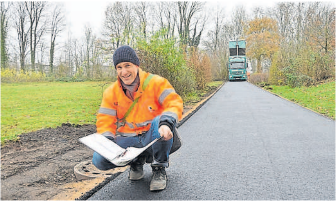
Fernando Quiroga von der städtischen Abteilung Straßenbau bei der Inspektion der letzten Arbeiten am Radweg im Bereich des Heidenturms. Foto: Stadt Ibbenbüren/André Hagel
