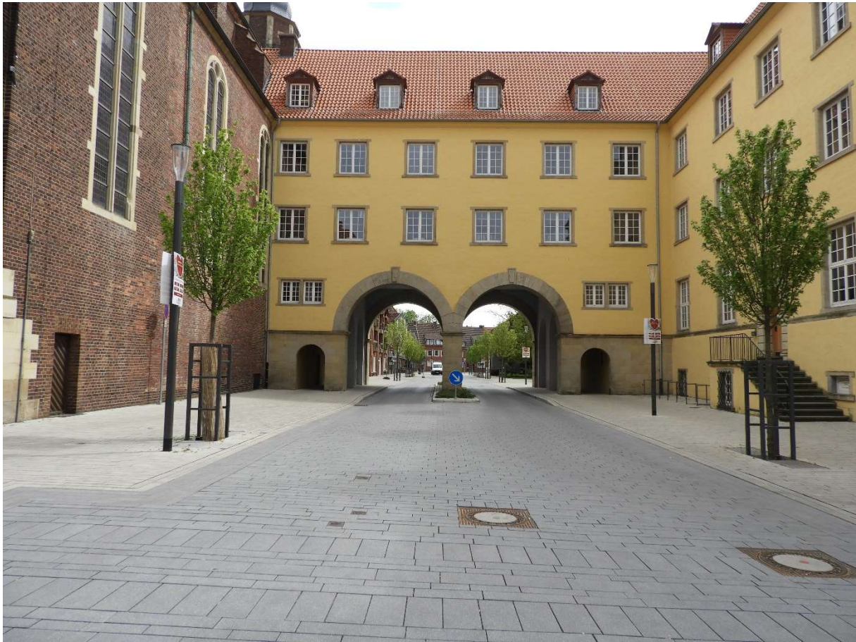
Die Tordurchfahrt, die beim Wiederaufbau eingebaut wurde.
