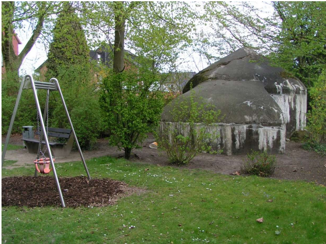
Luftschutzbunker am Roten Baum. Heute ist hier ein öffentlicher Spielplatz.
