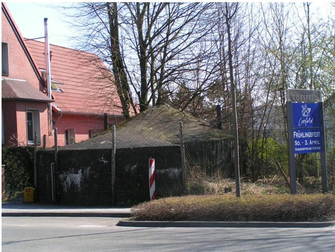
Luftschutzbunker an der Borkener Straße.
