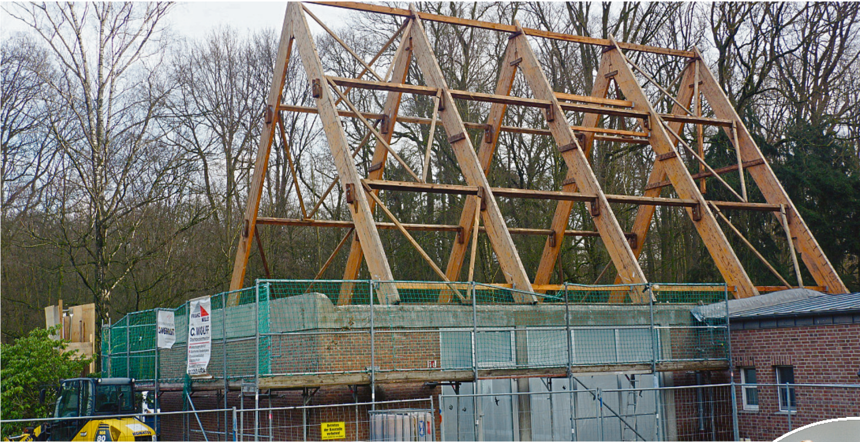
Komplettsanierung: Es stehen nur noch Dachstuhl und Außenwände der Gartenhalle. Der größte Seminarraum wird demnächst sehr viel flexibler. Michael Gennert, Leiter der LVHS, (rundes Bild) ist sehr zufrieden mit dem Ergebnis des schon fertig gestellten Umbaus. Fotos: Marion Bulla
