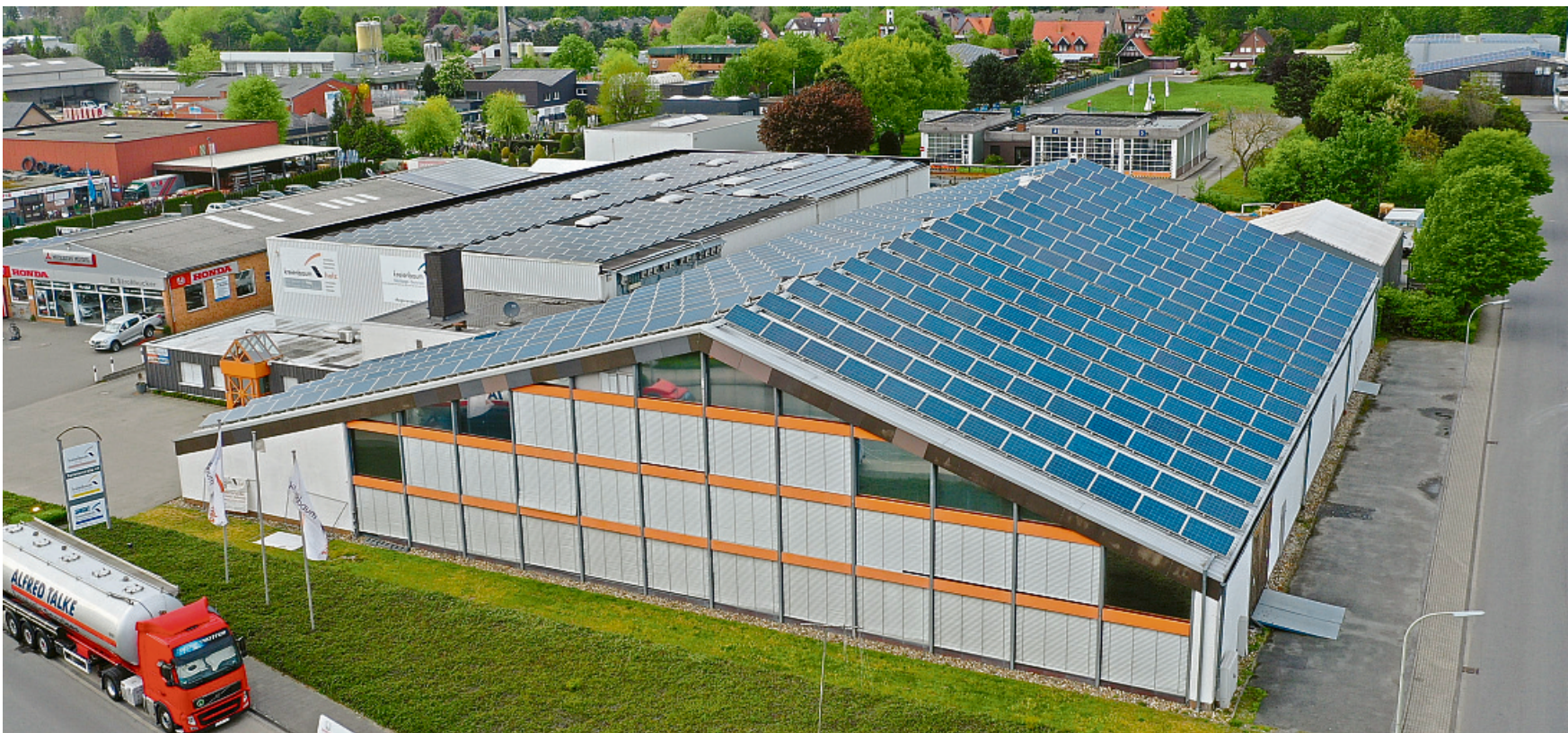
Nach dem 18. April wird der Betrieb in der Veranstaltungshalle an der Splieterstraße eingestellt. Dies gilt auch für die Partykneipe Q. Eine Prinzenproklamation wird es in der Veranstaltungshalle nicht mehr geben. Foto: Kreienbaum Holz
