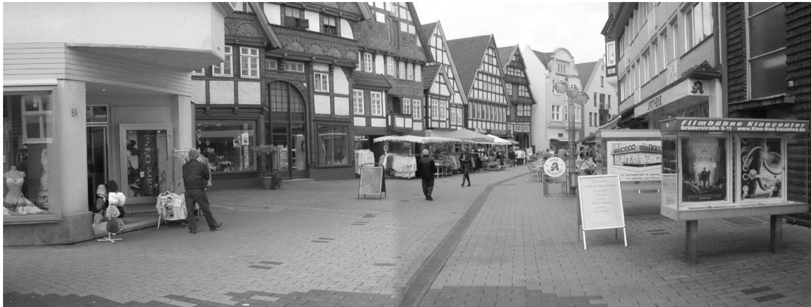
Lange Straße, Bestand
