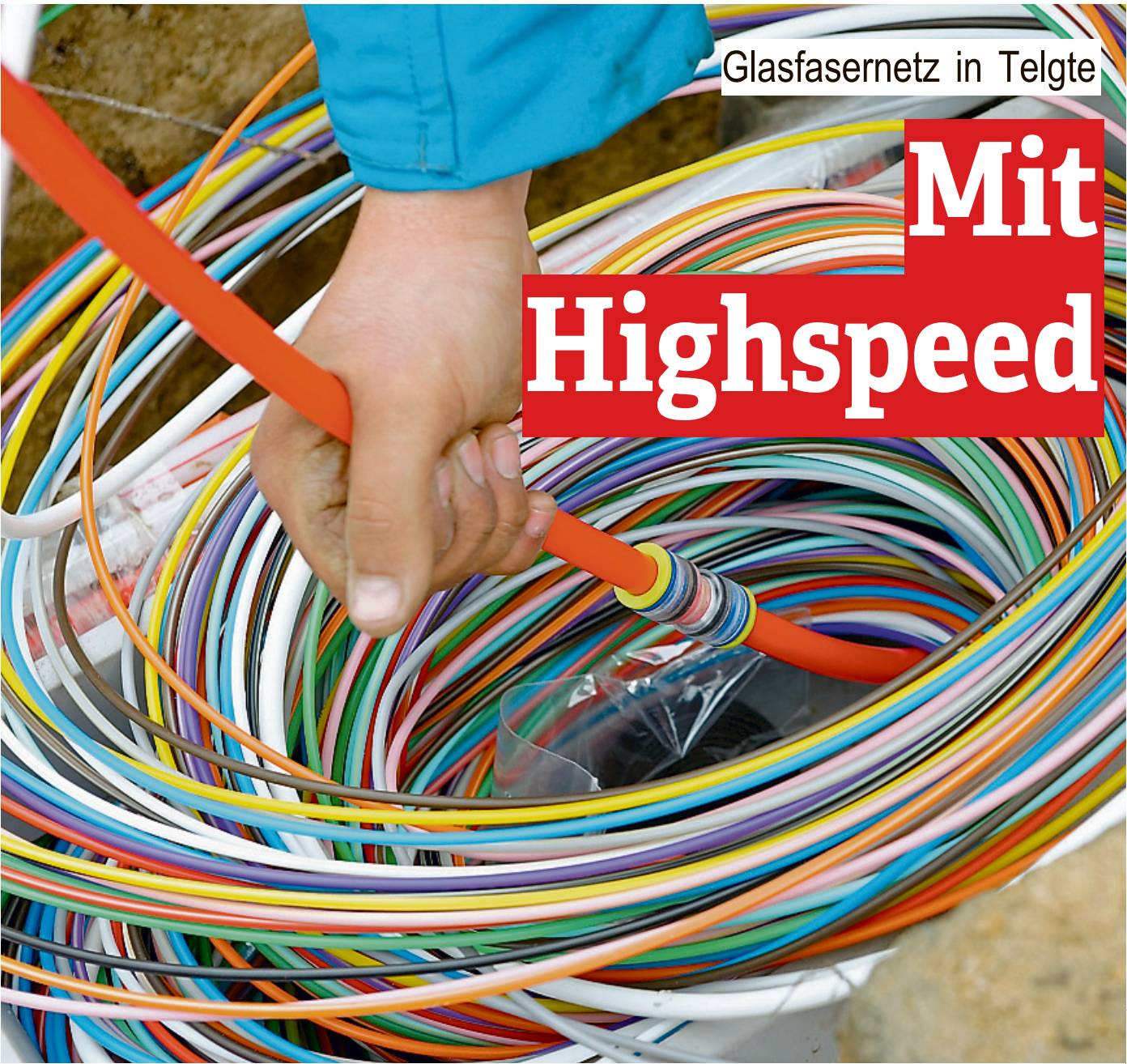
Die Deutsche Glasfaser wird ihr Glasfasernetz in Telgte verlegen. Foto: Deutsche Glasfaser / Martin Wissen
