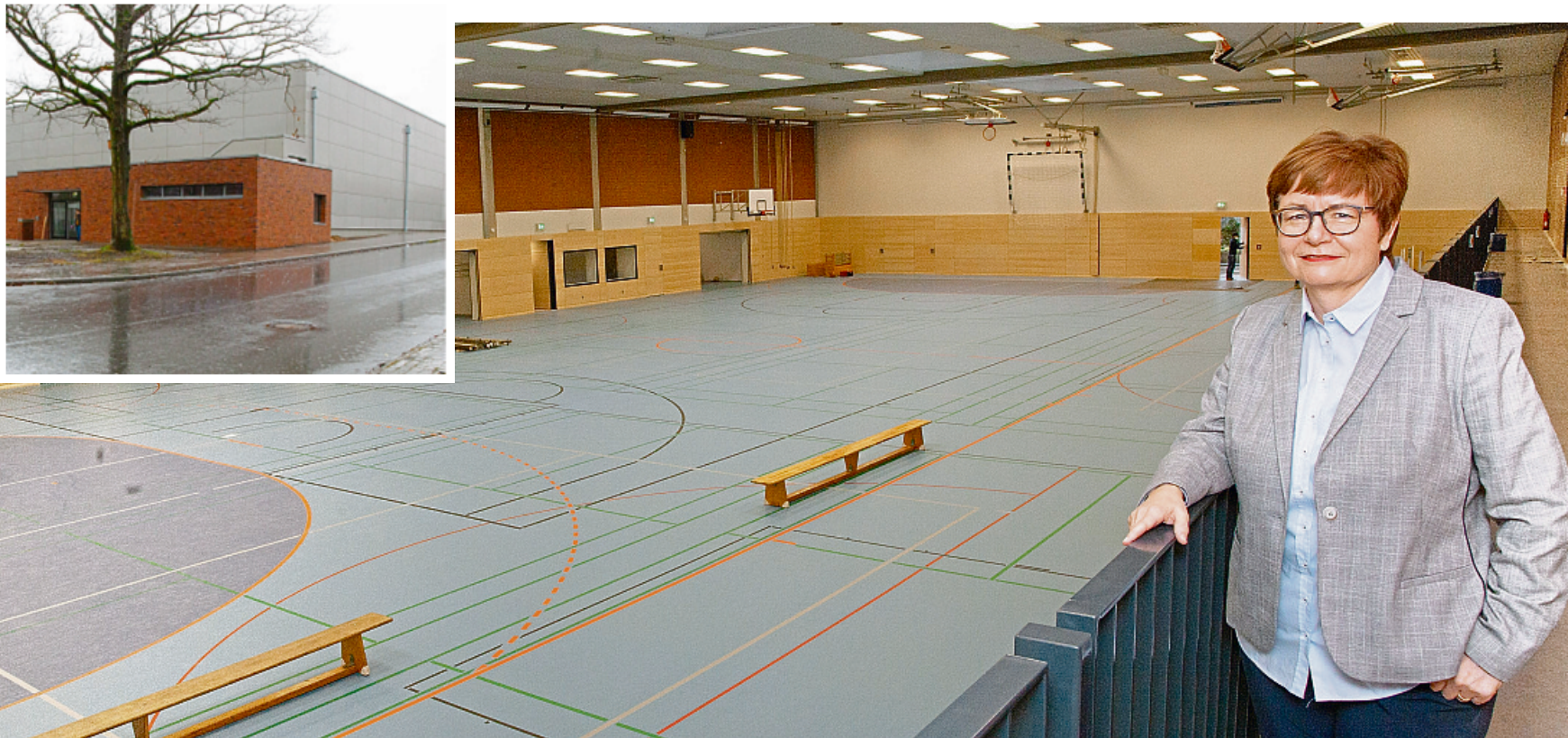
Mechthild Rövekamp-Zurhove, Schulleiterin des Maria-Sibylla-Merian-Gymnasiums, warf bereits einen Blick in die „neue“ Sporthalle. Die Sanierung ist abgeschlossen. Wann aber die ersten Nutzer hinein können, steht in den Sternen. Fotos: Bernd Pohlkamp
