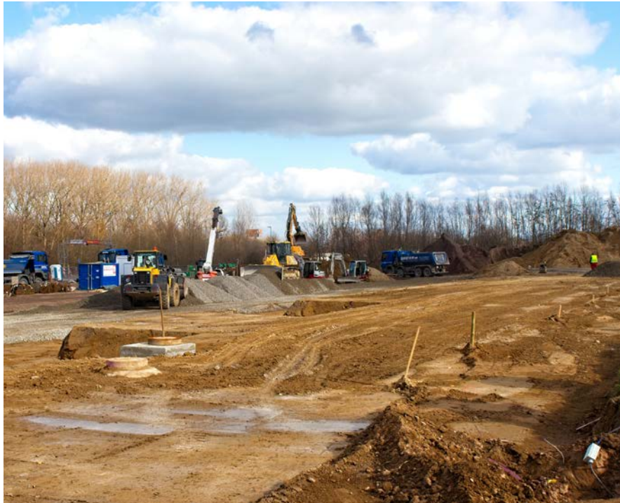
Für die Arbeiten am Fundament des Parkhauses sind größere Erdbewegungen notwendig.
