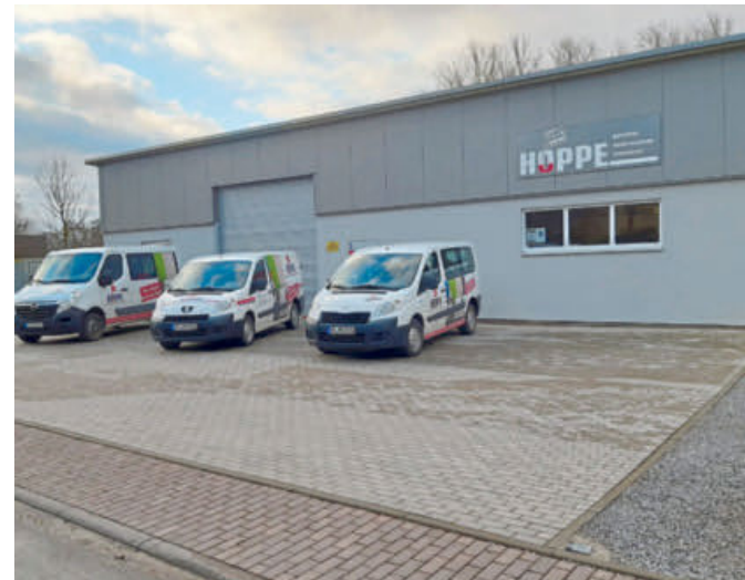
Rund 400 Quadratmeter überdachten Raum bietet die 2019 erbaute Lagerhalle, die der Malerbetrieb Hoppe im vergangenen Jahr bezogen hat.
