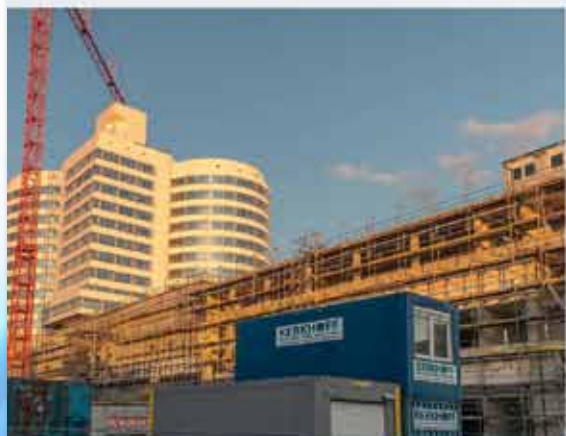
UKM Münster Sanierung der Bettentürme Ost und West
