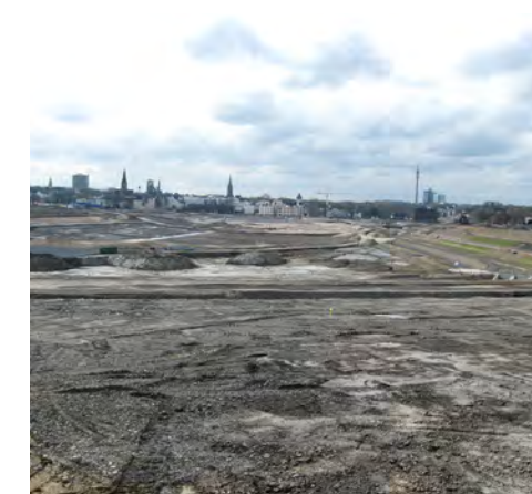
2010: Das Gelände nimmt Formen an
