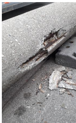
Austausch defekter Betonmasten
