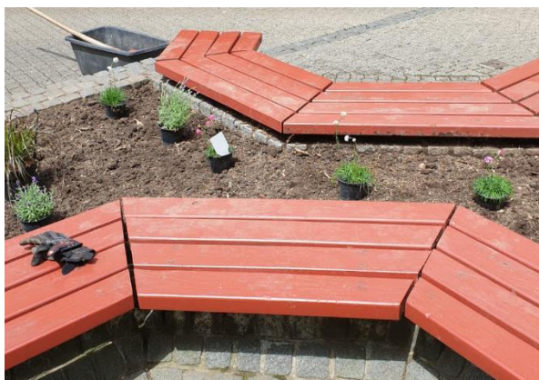
Fußgängerzone, Pflanzenarbeiten im Juni 2020
