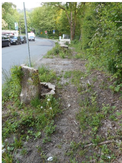
Blücherstraße vor der Instandsetzung
