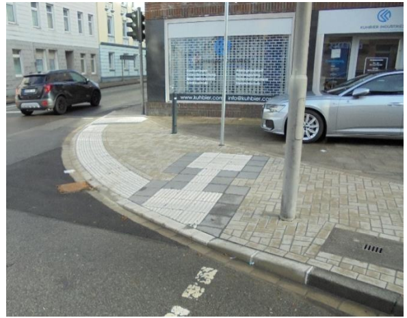
Barrierefreier Ausbau der Kreuzung Kaiserstr./Wilhelmstr.
