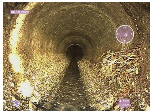
TV-Untersuchung schadhafter Kanalhaltungen Wurzeleinwuchs bzw. Rissbildung
