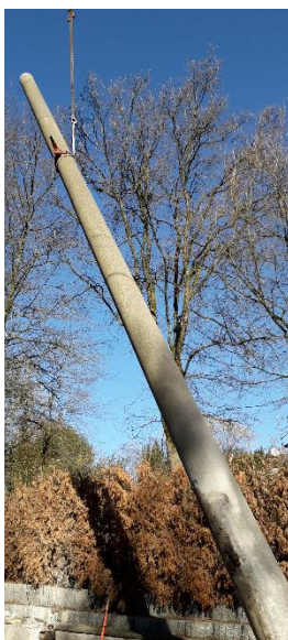
Austausch defekter Betonmasten
