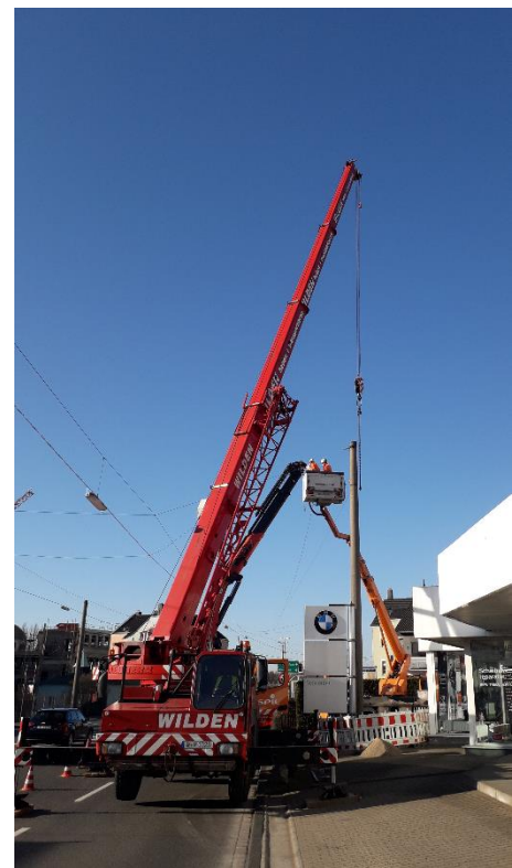
Austausch defekter Betonmasten
