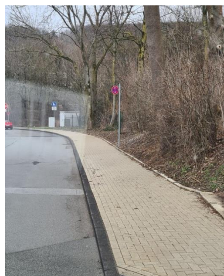
Blücherstraße nach der Instandsetzung
