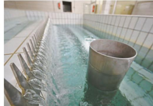
An dieser Station läuft das vorgefilterte Wasser ein, Kiesreste setzen sich dabei am Beckenboden ab.
