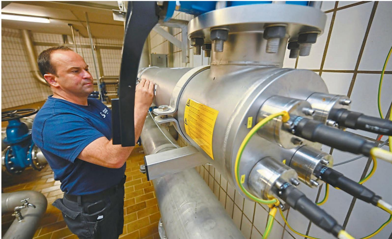
In diesem Edelstahlrohr ist die UV-Technik an der Filteranlage Scherfedehardehausen verbaut. Sebastian Maicher, Netzmeister der Stadtwerke Warburg, prüft die Apparatur.
