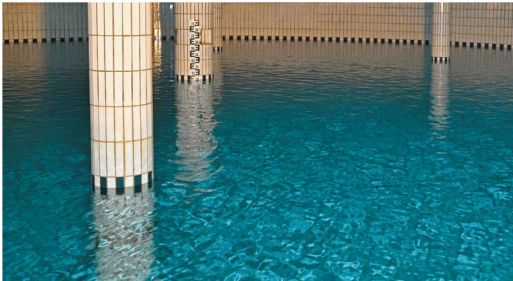
Nach der Reinigung und Desinfektion fließt das Trinkwasser in diesen Hochbehälter vor Ort – und von dort aus ins Rohrnetz und zu den Verbrauchern.
