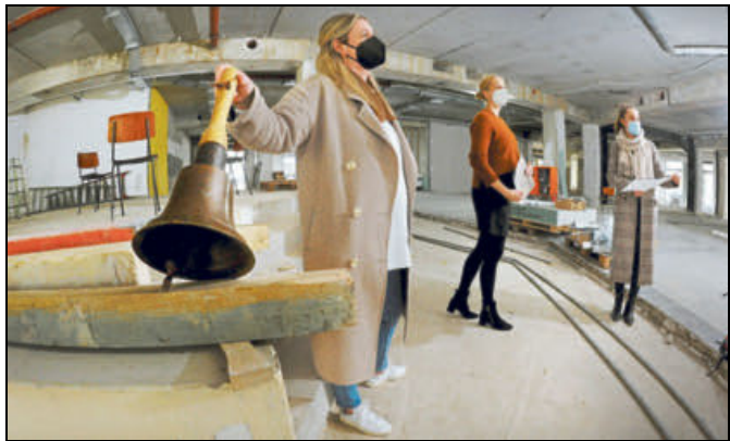
Sarah Seebode hält die Original-Glocke von Wilhelm Harms. Sie nimmt mit Britta Herbst und Olga Jaschin die Baustelle in Augenschein.
