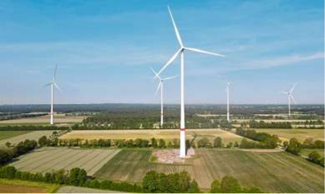
Mit seinen 13 Windkraftanlagen gehört der Windpark „Letter Bruch“ zu den größten in Nordrhein-Westfalen. Foto: 3 Emergy
