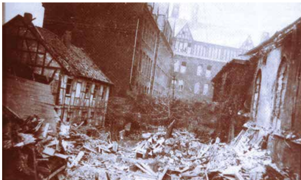
Trümmer der Buchhandlung, beschädigte Gymnasialkirche 1944 (Foto: Winkelmann)
