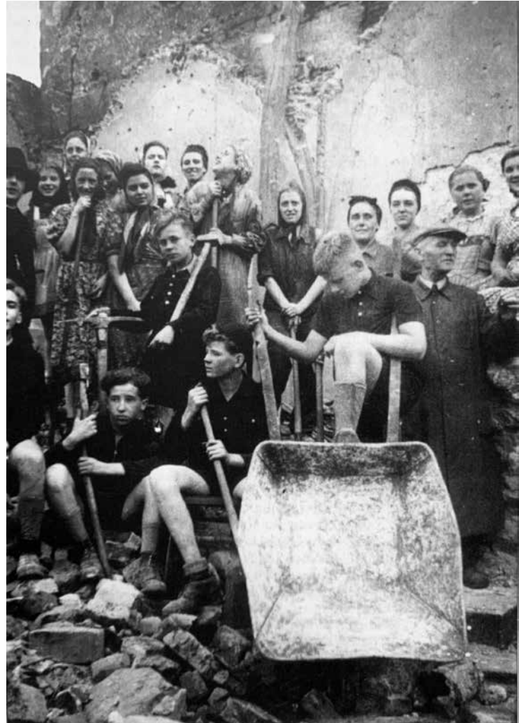
Aufräumarbeiten in St. Peter (Chronik Kaplan Kösters)
