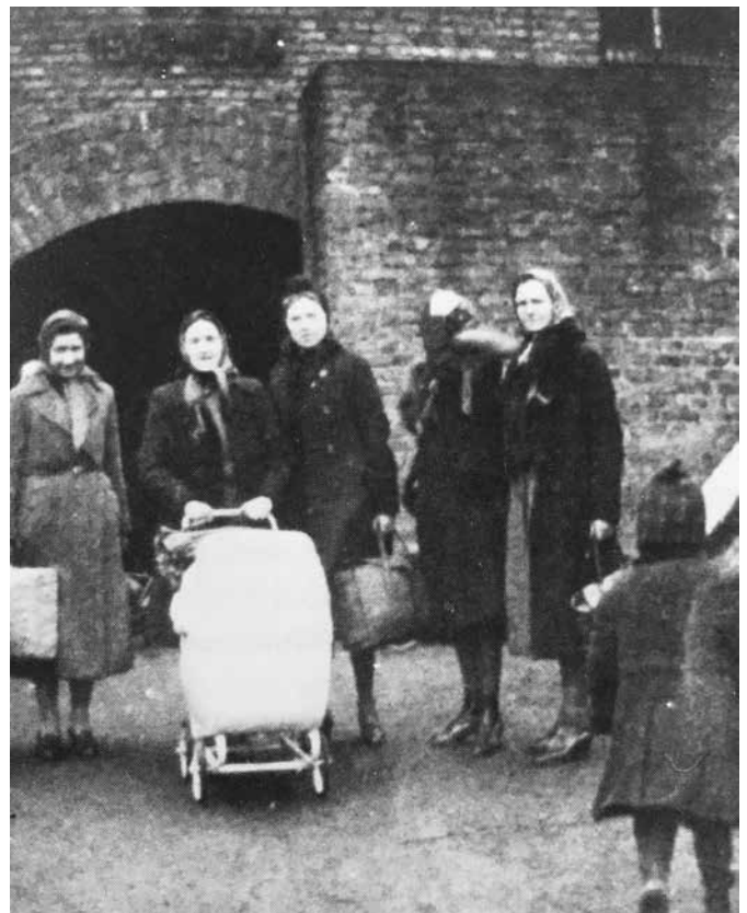
Stollenbunker Halde Wanner Straße 1943 (Hochlarmarker Lesebuch, S. 191)
