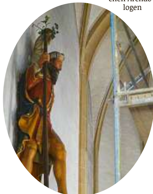
Der Hl. Christophorus wacht über die Sanierung.
